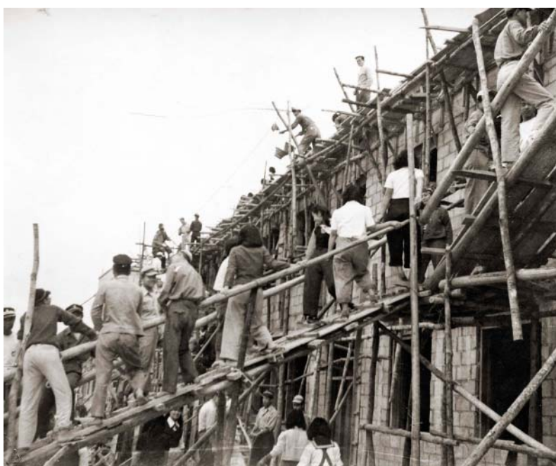
戦後の沖縄では、素人でも作りやすかったCB(コンクリートブロック)造も普及した。学校建築ではPTAを中心に、大人も子供も加勢した。写真は那覇高校の校舎建設の様子。春休み、懸命に作業に励む生徒たち＝1952年3月25～27日、那覇高校
